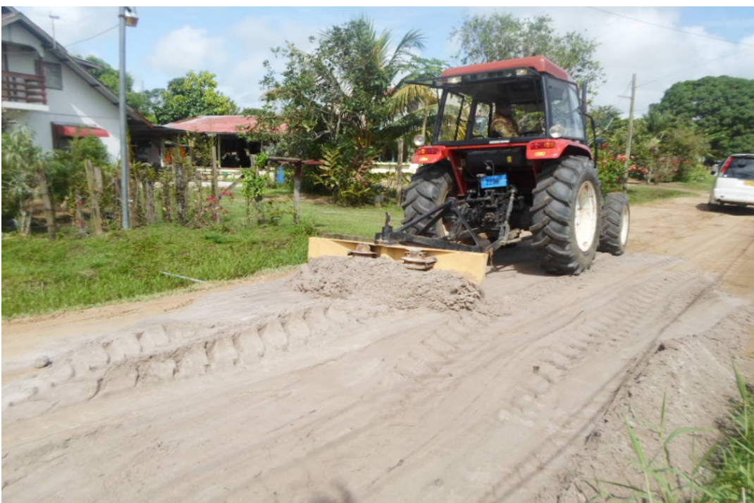
De Palissadeweg wordt bezand en geëgaliseerd
