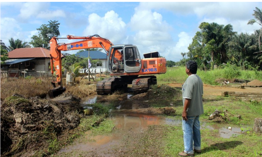
Een machine van de aannemer Main Transport bij het startpunt van de werkzaamheden op Bernhardsdorp West
